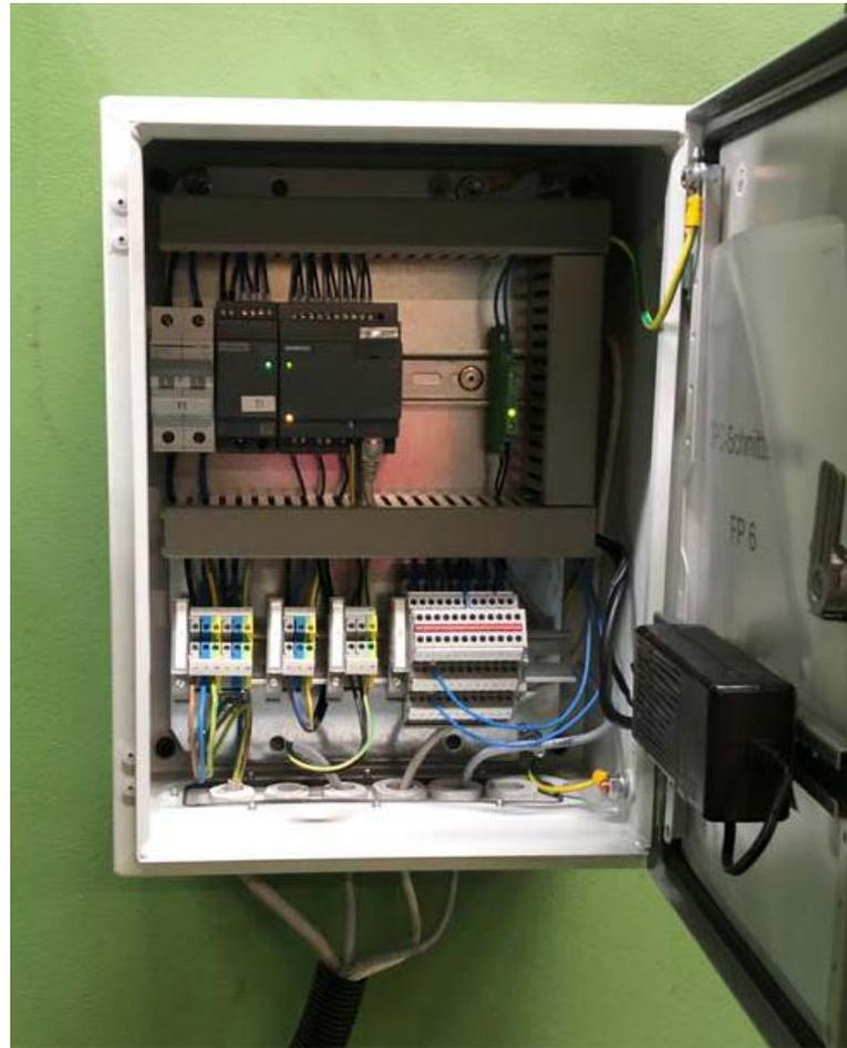
Optionales Zubehör: Vorverdrahteter Schaltkasten zur externen Maschinenmontage
